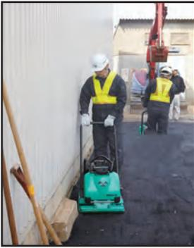
Con las adecuadas fuerzas de compactación para realizar una óptima compactación del asfalto.
