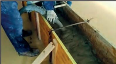
**BOMBEO DE MORTEROS Y MICROHORMIGONES, CON ARIDOS DE HASTA 8 MM.**
