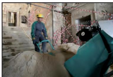
Esscráper/mullilla "opcional", de tracción hidráulica, para facilitar la carga de los materiales sobre la tolva/skip, reduciéndose el esfuerzo personal, y agilizándose el ciclo de trabajo
