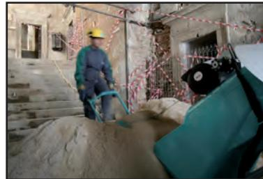
Esscráper/mulilla "opcional", de tracción hidráulica, para facilitar la carga de los materiales sobre la tolva/skip, reduciéndose el esfuerzo personal, y agilizándose el ciclo de trabajo
