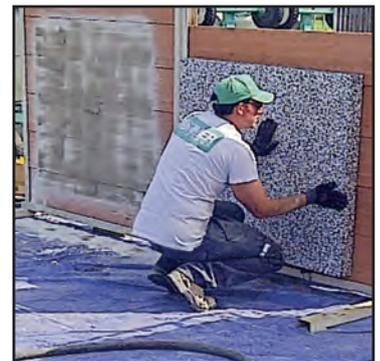
Colocación del panel "EPS" termoaislante
