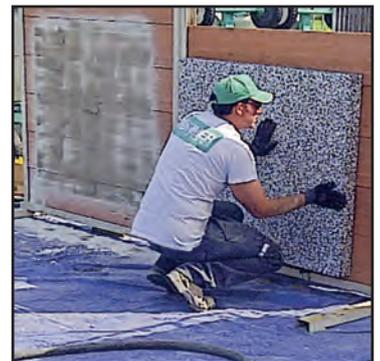
Colocación del panel "EPS" termoaislante
