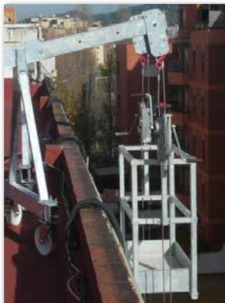
Cabina BASIC 500 de 1.60 m de longitud con 2 elevadores manuales
