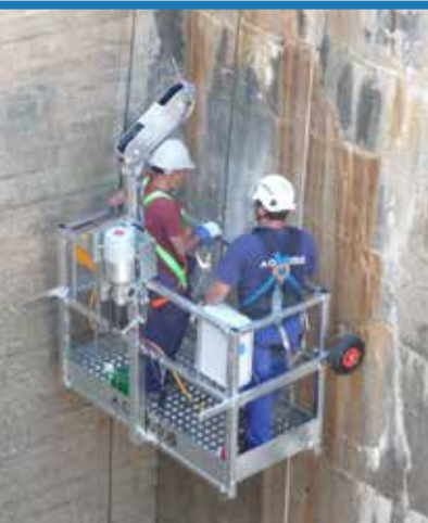
Cabina BASIC de 1.60 m de longitud con elevador eléctrico
